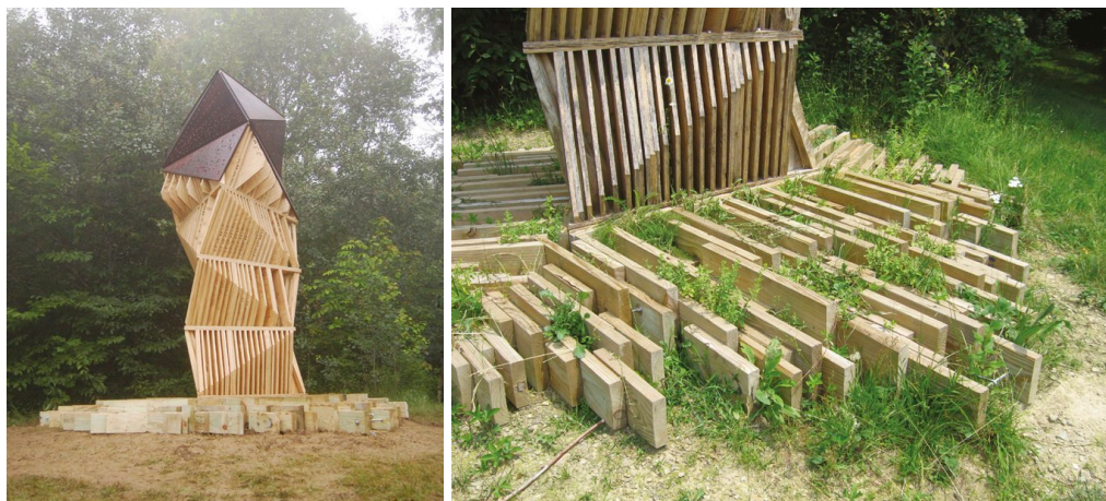
Fig. 3 Dispositivo experimental Bat Tower , diseñado por Joyce Hwang (Buffalo/Kamogawa). Izquierda: elevación general del dispositivo de madera contrachapada estriada, proyectado para el resguardo térmico de colonias de murciélagos (fotografía de Joyce Hwang, 2010). Derecha: detalle de la base porosa del artefacto y colonización espontánea por parte de vegetación ruderal (fotografía de Joyce Hwang, 2010). Fuente: Archivo del proyecto Bat Tower , Universidad de Buffalo (SUNY), cortesía de Joyce Hwang.
