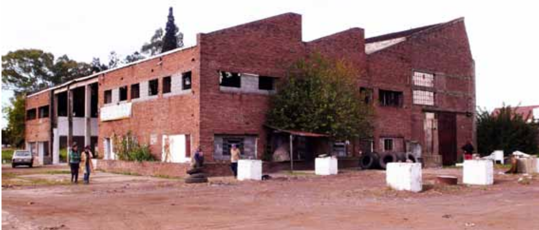
04 Ex fábrica Roca Negra, edificio principal
