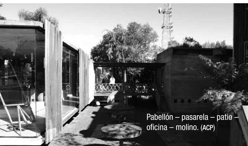
Molino y Oficina. Al fondo el Pabellón de Exposición. Nótese el contraste entre los núcleos de madera y hormigón, cuyos tonos se van a asemejar a lo largo del tiempo. (NK)
