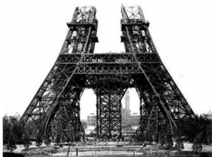
Atlas Photo, FL-7 Montage des piliers au-dessus du premier étage (15 mai 1888)
