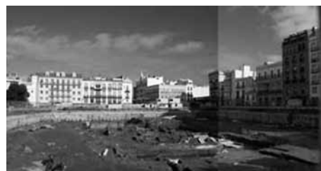
Estado del solar en 2004. 17.200 m 2 de estudio Muros pantalla perimetrales, realizados para el abandonado proyecto de Carbajal
