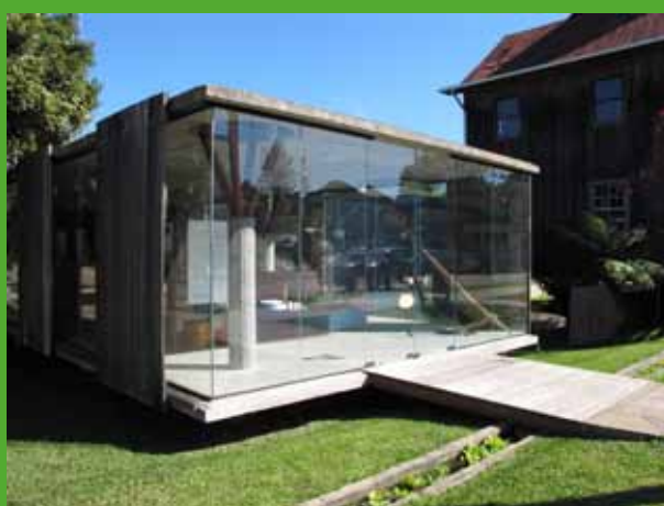
Acceso al Pabellón de Exposición. (ACP)
