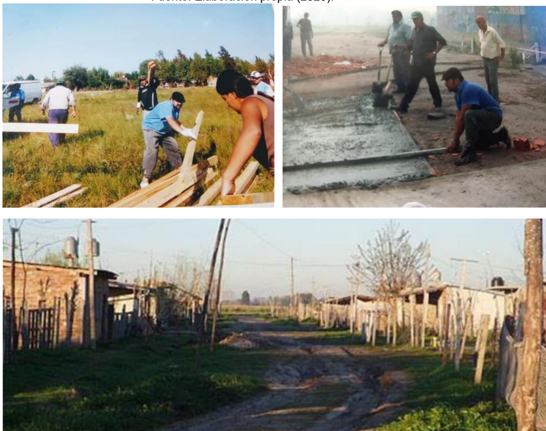
Figura 2: La periferia como frontera de marginalidades Fuente: Elaboración propia (2020).
