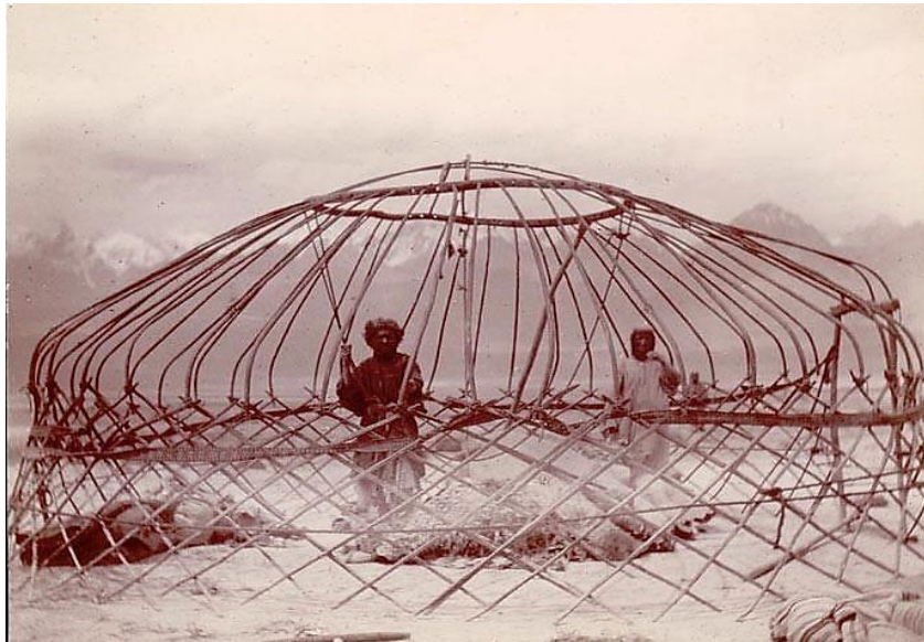
Figura 1 Estructura de yurta en construcción. Recuperado de http://www.laozhaopian5.com/qingchao/1380.html
