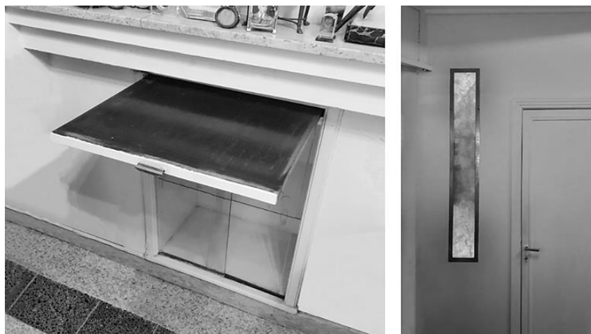
Figura 7. Casa Chizzini Melo. Izquierda, mueble fijo para “bar”, con puertas de vidrio corredizas, iluminación eléctrica en su interior y bandeja superior extraíble; el interior es de mampostería revocada. Derecha, dormitorio principal: raja de iluminación con frente en piedra traslúcida, contigua a puerta de placard embutir. Fotografías J. Segarra, 2020.
