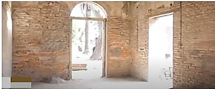
Muros perimetrales portantes Arcos
