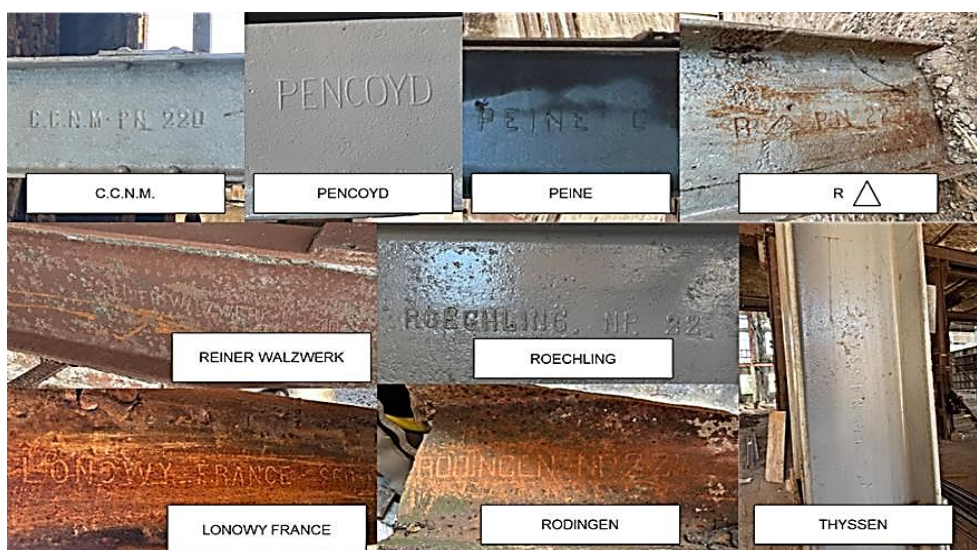
Figura 6. Perfiles de procedencia extranjera encontrados en el Ingenio San Pablo. Fuente: fotografías y elaboración propia.
