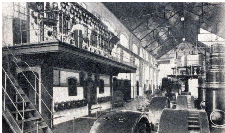
Imagen 15: interior de la vieja usina Sorrento. Fuente: FAPyD-UNR
