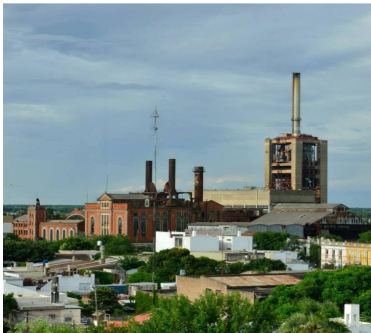
Imagen 17: instalaciones viejas y nuevas en Sorrento. Fuente: diario La Capital
