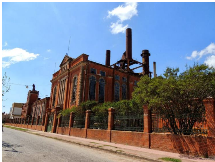
Imagen 12: La usina por la calle Hernández. Fuente: propia
