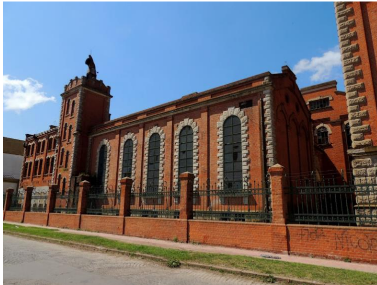
Imagen 13: Edificio vieja usina. Fuente: propia
