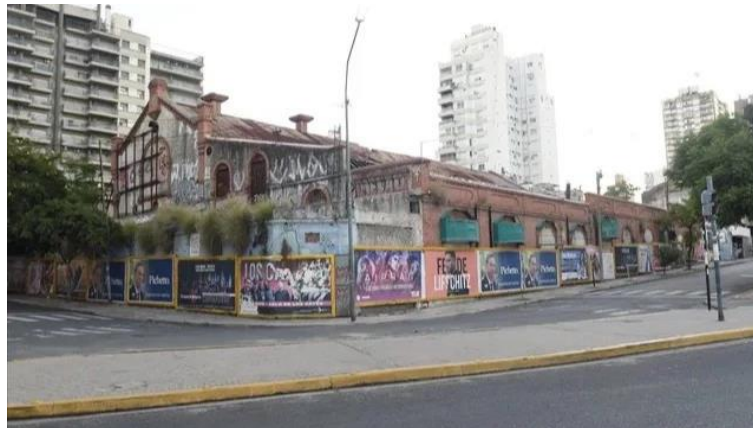
Imagen 8: estado de las instalaciones hoy en San Martín y Catamarca 2025. Fuente: Diario La Capital
