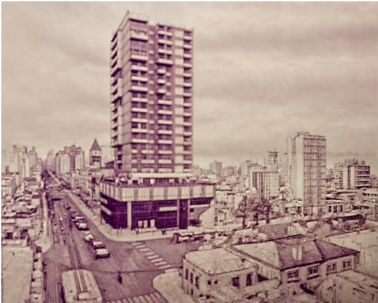
Imagen 8 Tomás Cicceró. Edificio Litorcoop Coop. Ltda y Torre de departamentos, 1977. Fuente: Fotografía del archivo personal de Cicceró, mejorada con IA
