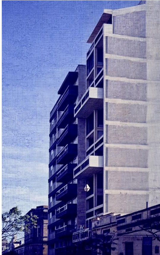
Imagen 5 Tomás Cicceró. Edificio Sistema 5 , 1977. Fuente: Fotografía del archivo personal de Cicceró, mejorada con IA
