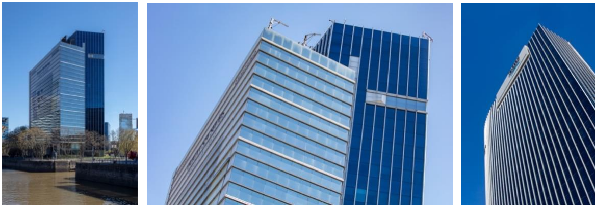
17. Edificio Telecom/Personal Flow (1995/97) Kohn Pedersen Fox Assoc. (KPF)+ Hampton-Rivoira. Detalles montantes verticales y horizontales
