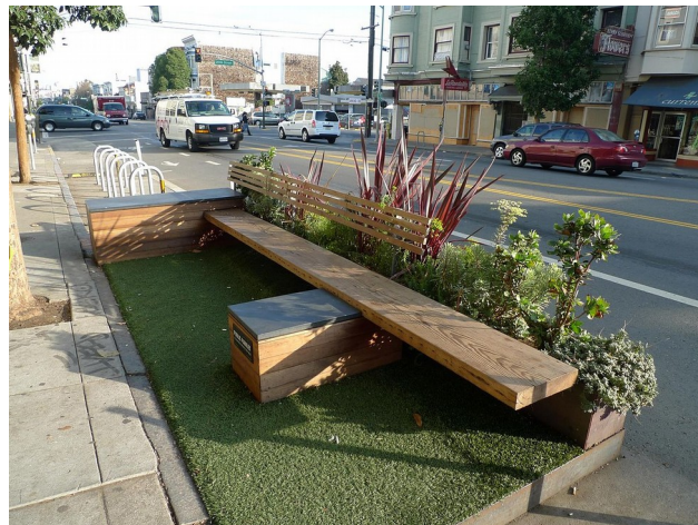
Imagen 5: Típico parklet en San Francisco, sobre la calle Valencia. Nótese la continuidad con el nivel de vereda, la configuración como plataforma desmontable, y la presencia de asientos y macetas con plantas
