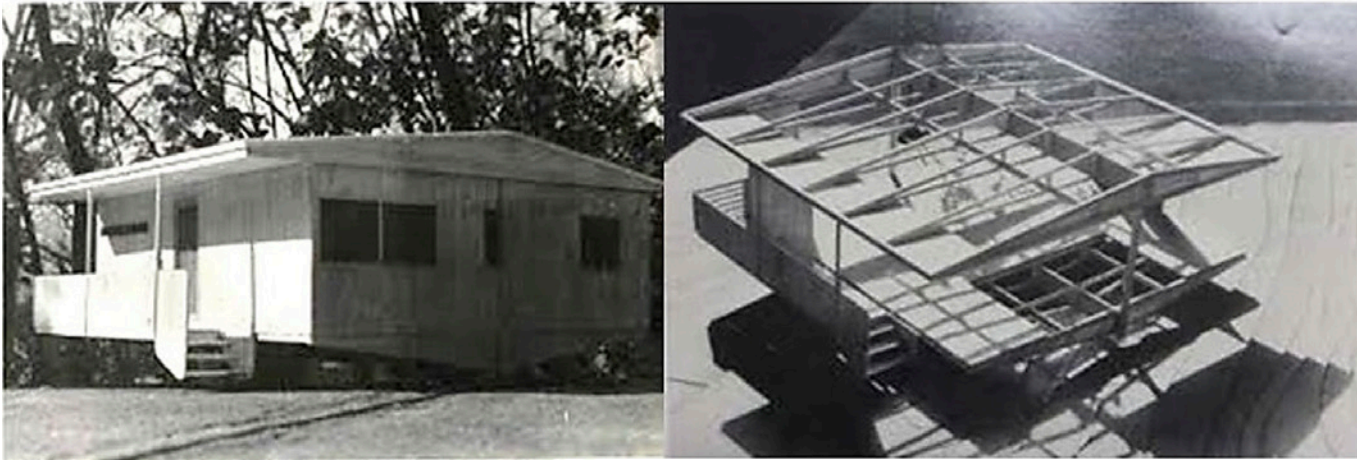
Imagen 8. Casa prefabricada Plas -2 point- Imagen exterior y estructura que muestra el sistema de transferencia de cargas hacia el interior de la casa y minimiza su contacto con el suelo
