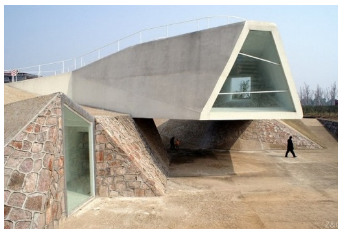
Tatiana Bilbao. Parque Arquitectónico de Jinhua. China
