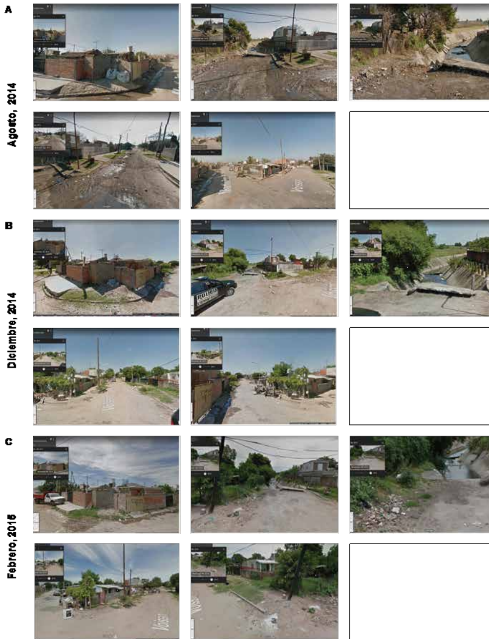
Imágenes extraídas de la aplicación Google Street View. Las mismas fueron tomadas por la flota de Google en agosto 2014 (a), diciembre 2014 (b), febrero 2015 (c). Referencia territorial: Calle Voissin 2198, Gregorio de Laferrere, La Matanza, Buenos Aires.
