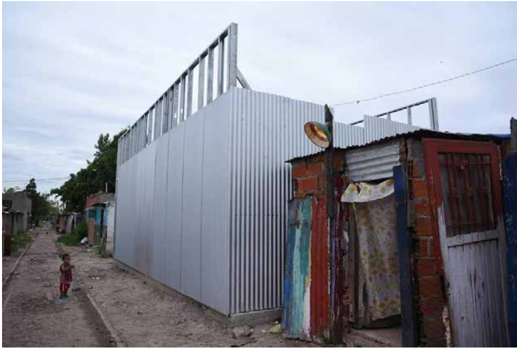
Imagen 9 (arriba) Casa de las 3 Hermanas en construcción
