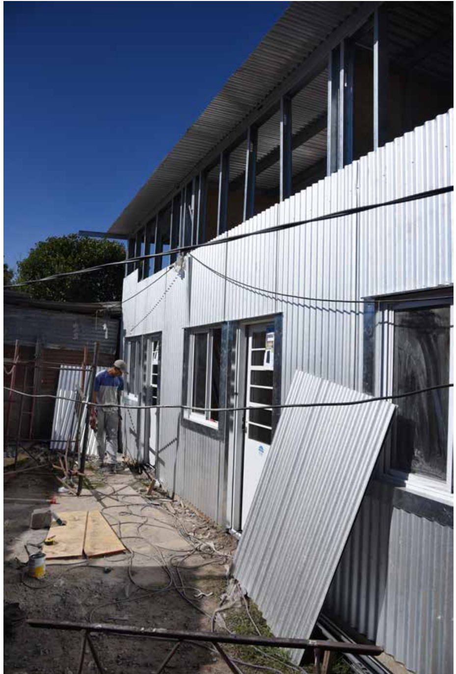
Imagen 8 Casa de las 3 Hermanas en construcción
