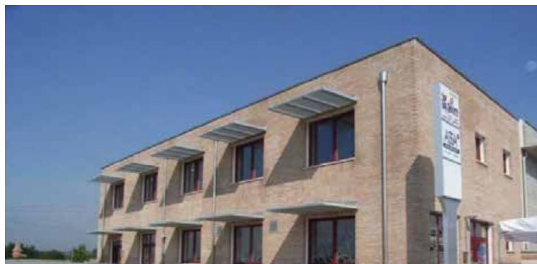
Imagen 1 Edificio de oficinas ASSA. Silvia Mazzetti. Bolonia, Italia. 2005-2007.
