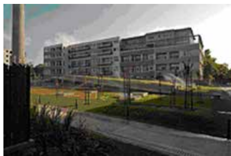
Fig. 14: Vista del Espacio Central del Conjunto Tronador. Fuente: http://www.laopinionrafaela.com.ar/
