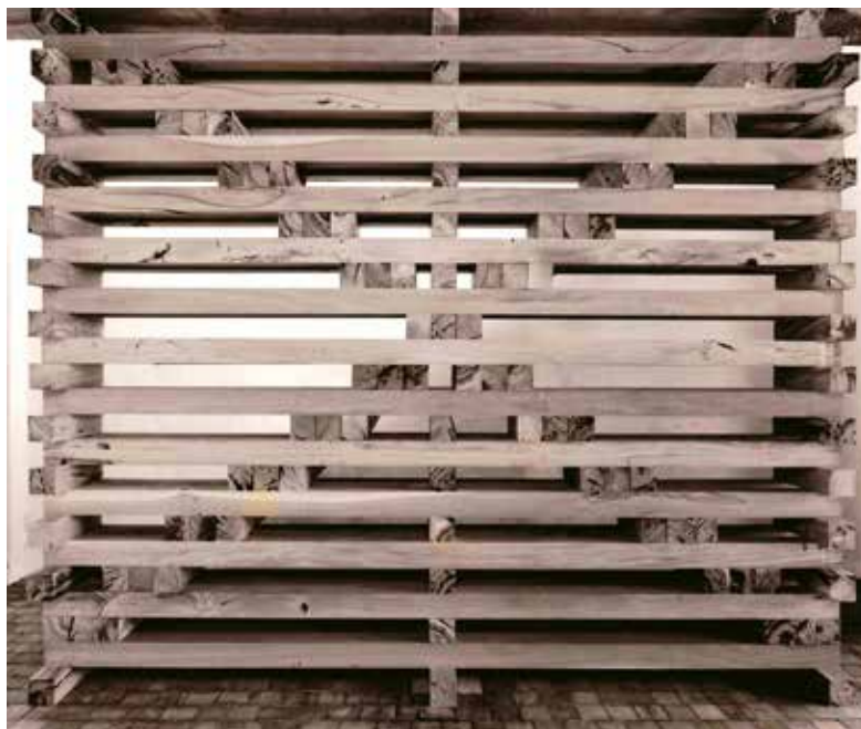
Figura 13 R.Iglesia Escalera Casa Del Grande
