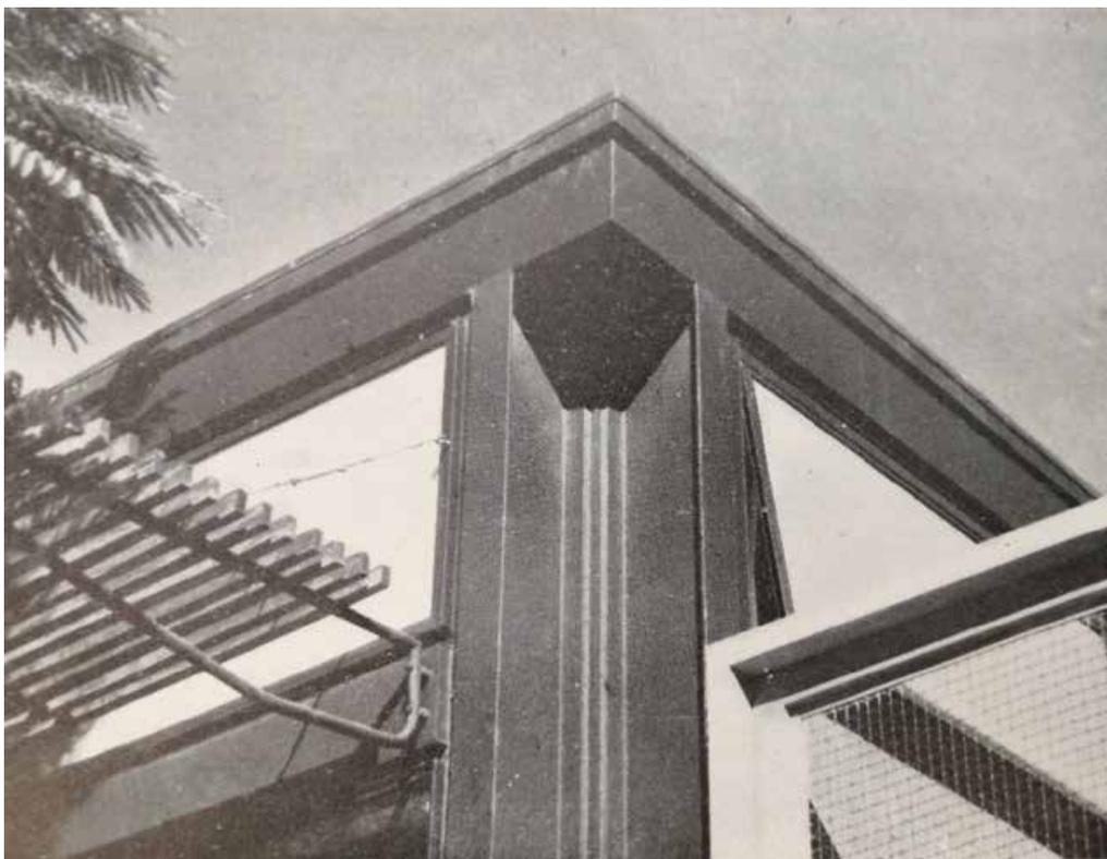
la inercia– sería colocar las almas de la columna en la dirección de la viga del pórtico y no en la línea del forjado como las colocó. En este caso, estamos frente a una decisión puramente visual.
