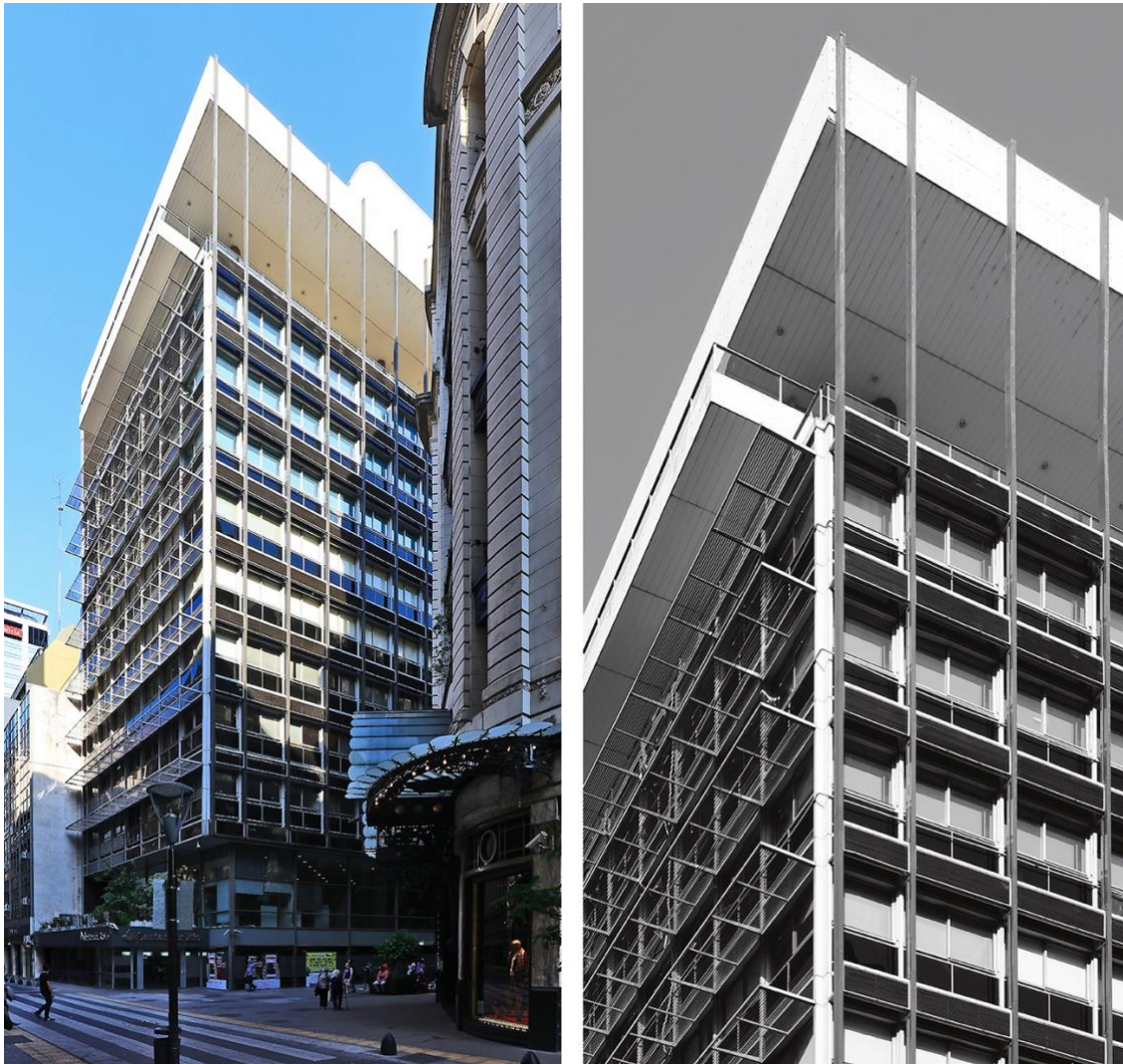
Imágenes 6A-6B Fotografía urbana y detalle cerramiento Pablo Corral. 2019 ©
