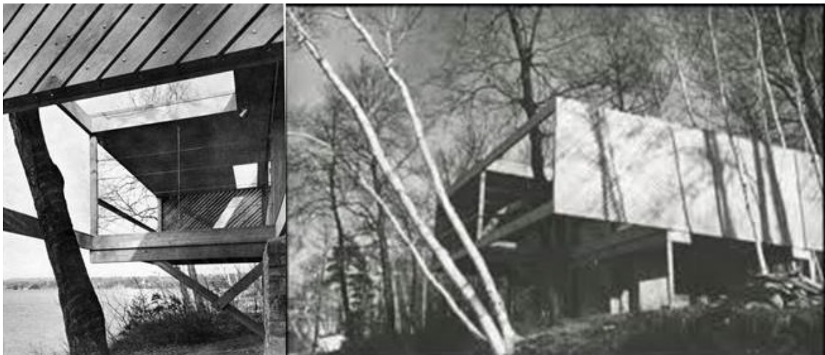
Imagen 6. Caesar Cottage. Imágenes de la cabaña que proyecta sus visuales hacia el entorno a través de un entramado portante exterior permeable.
