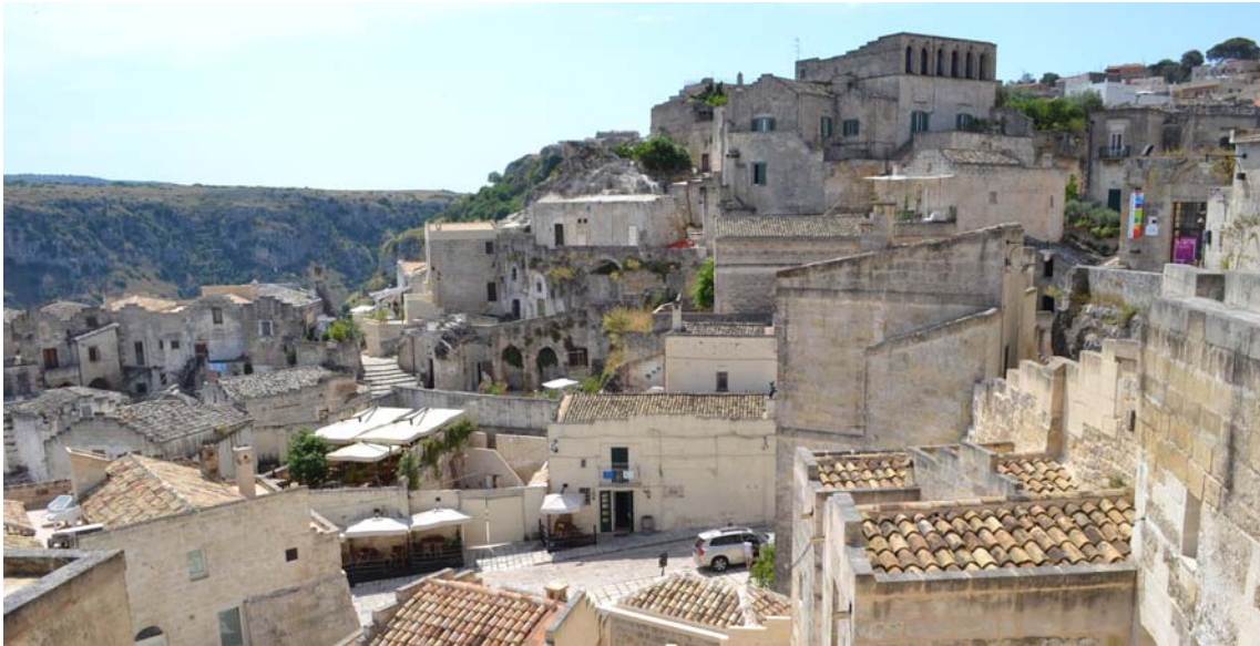
Matera, Basilicata, Italia. Las casas de esta ciudad en realidad son prácticamente cavernas de donde se extrajo el material con el que se conformaron los espacios o las habitaciones que dan forma a la ciudad. Una estrategia de aprovechar las condiciones geológicas para conseguir un asentamiento de bajo consumo energético y respeto por el ambiente. Fuente: Arq. Pedro Pesci
