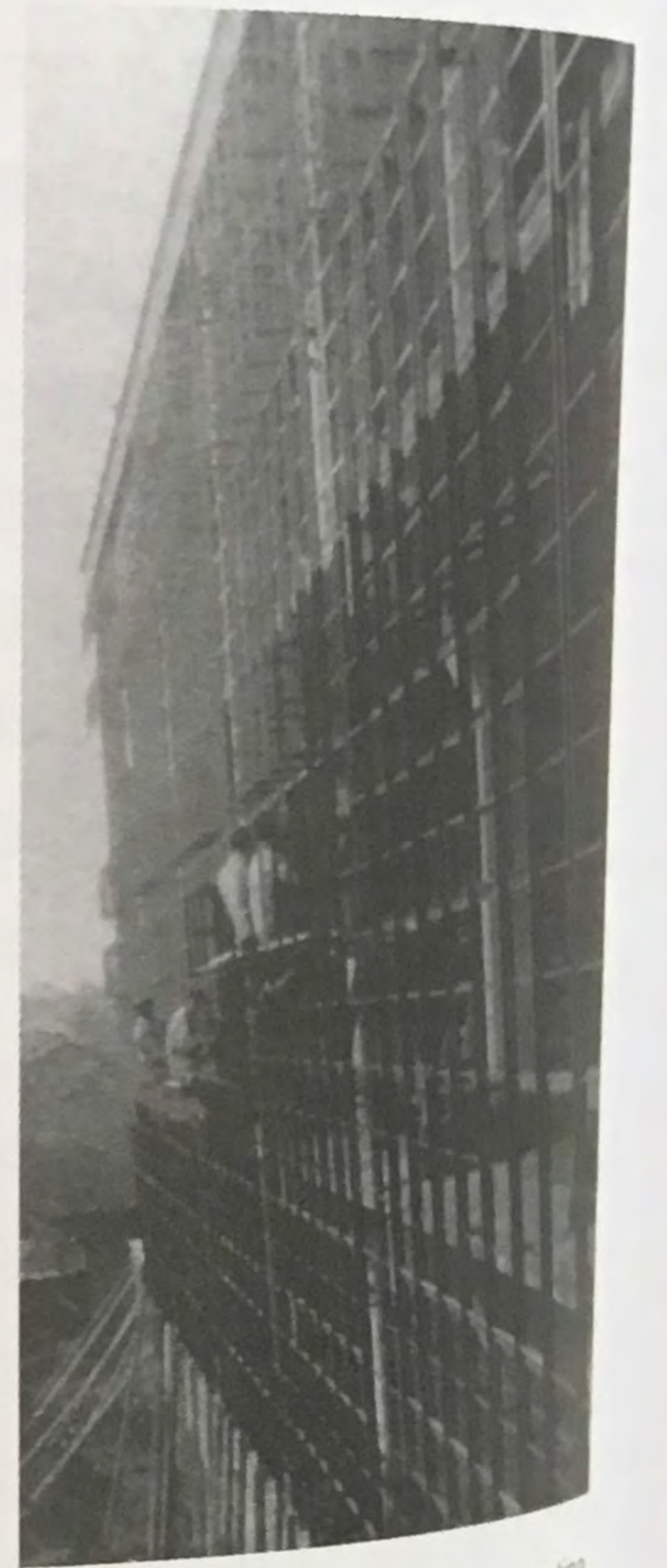
38. La construcción del muro-cortina
