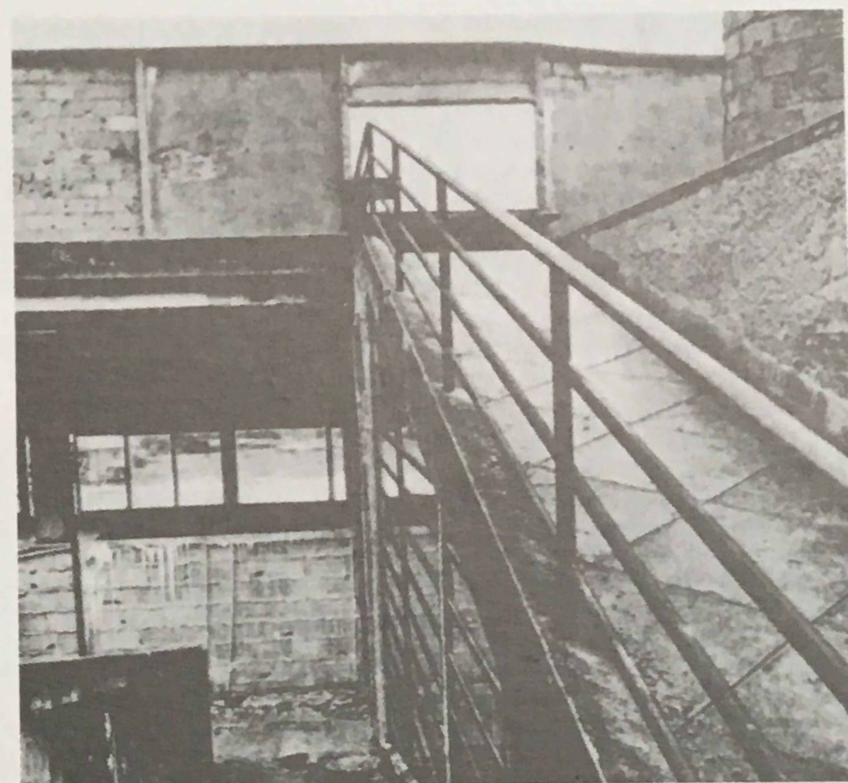
27. Una de las fotografías de Guillermo Jullian de la Fuente encargadas por Le Corbusier para documentar el estado del edificio
