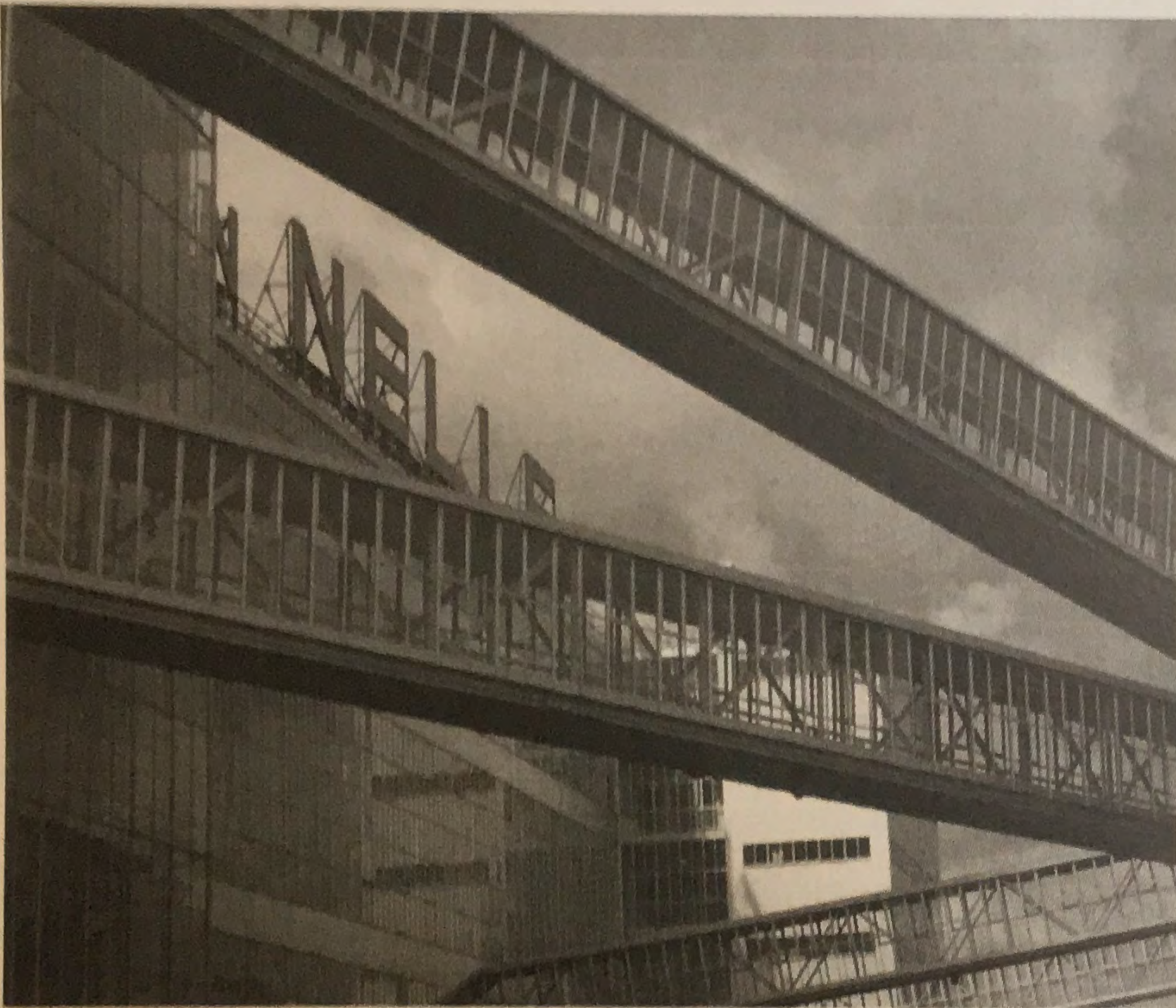
63. Las pasarelas y el neón superior restaurados
