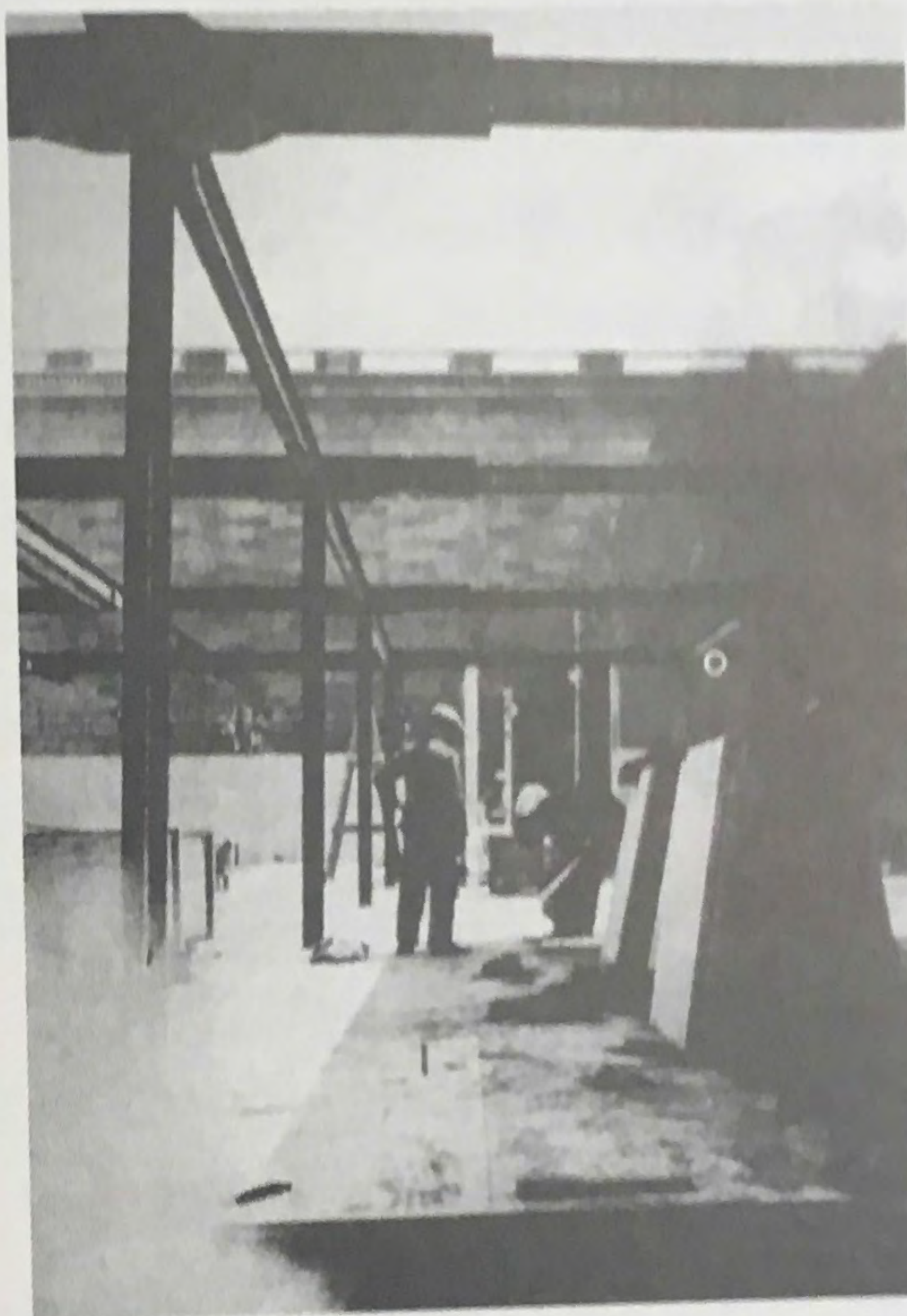
76. La estructura de pórticos metálicos en construcción; abajo, las losas de travertino
