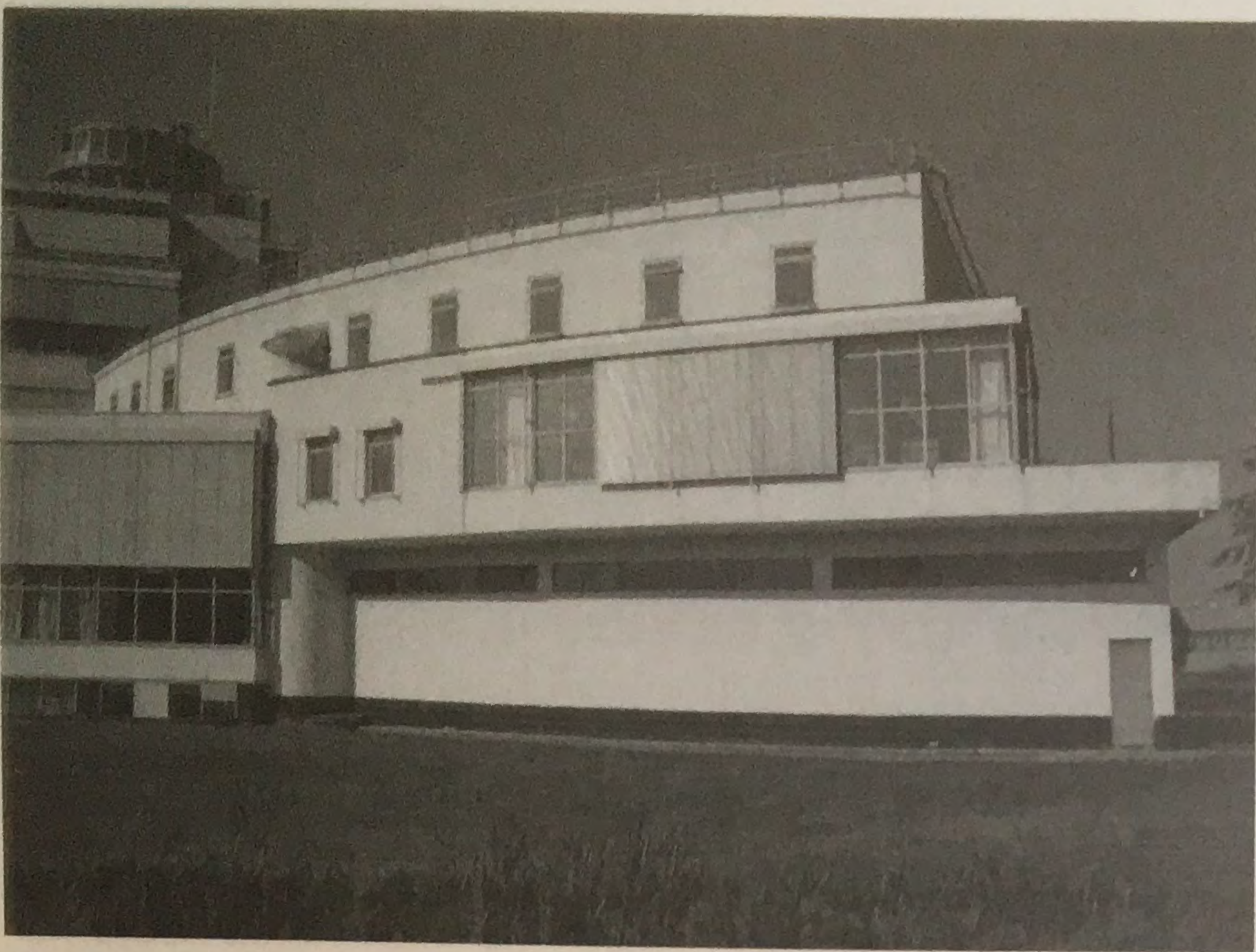
61. El edificio de oficinas restaurado
