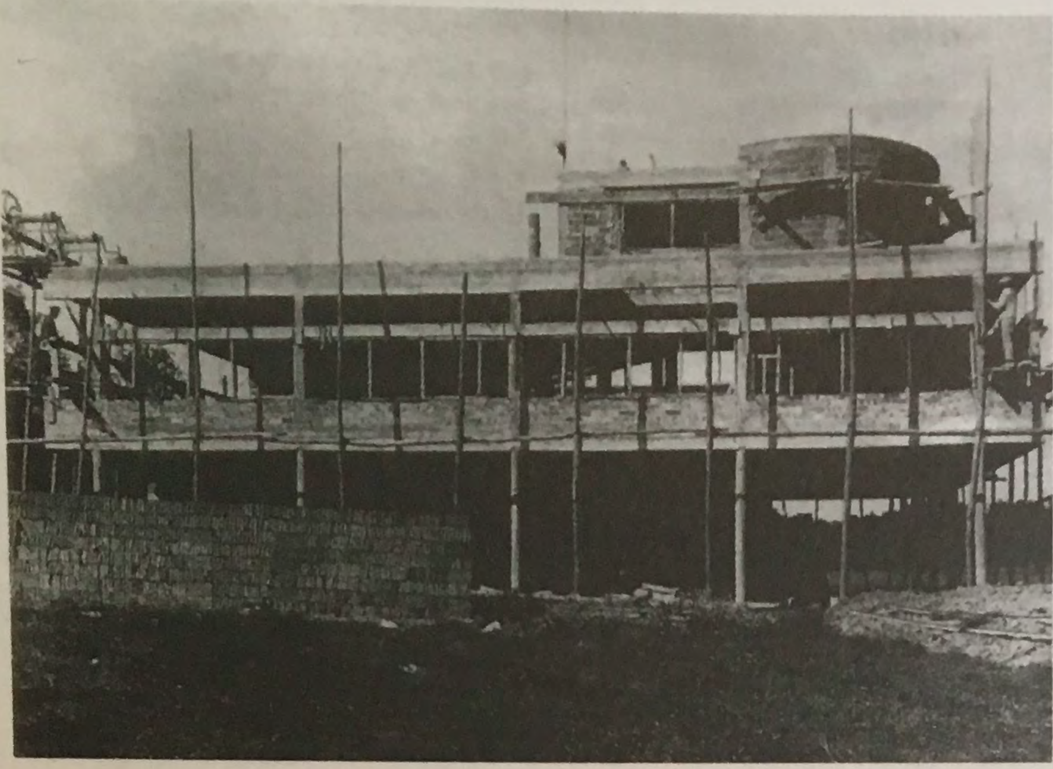
22. La villa en construcción
