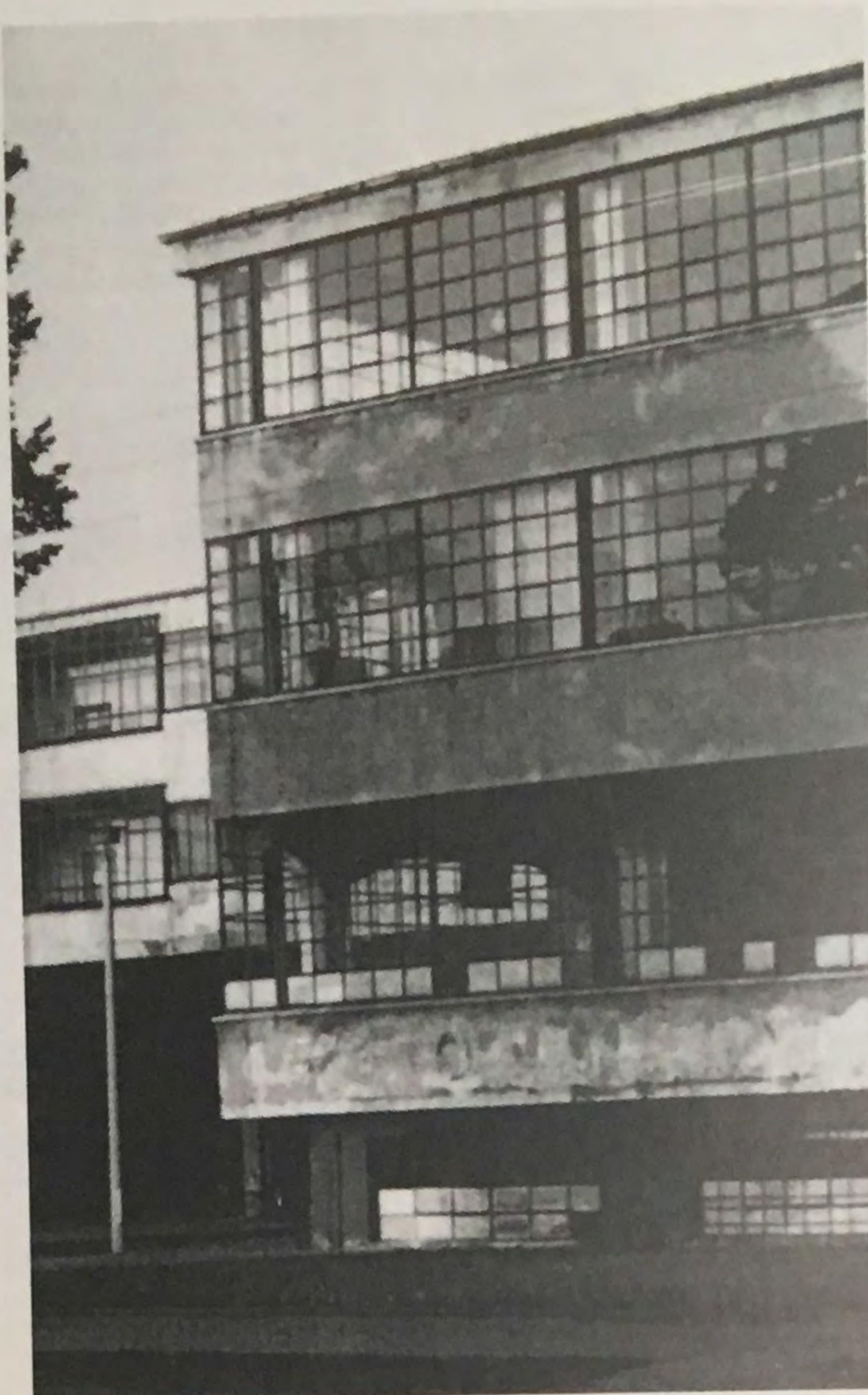
42. La rehabilitación del ala de los talleres, con ventanas corridas
