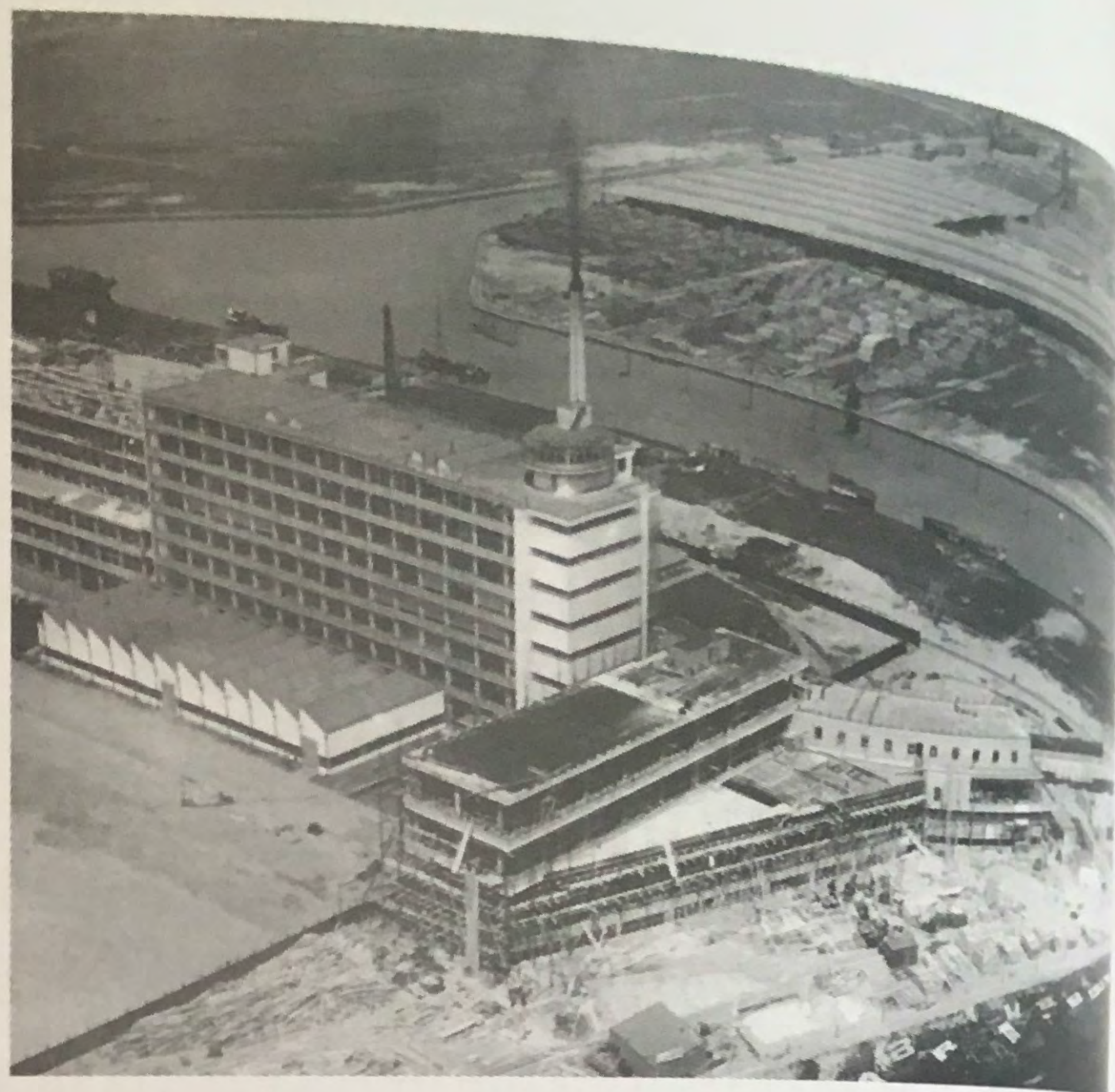
56. El conjunto en construcción
