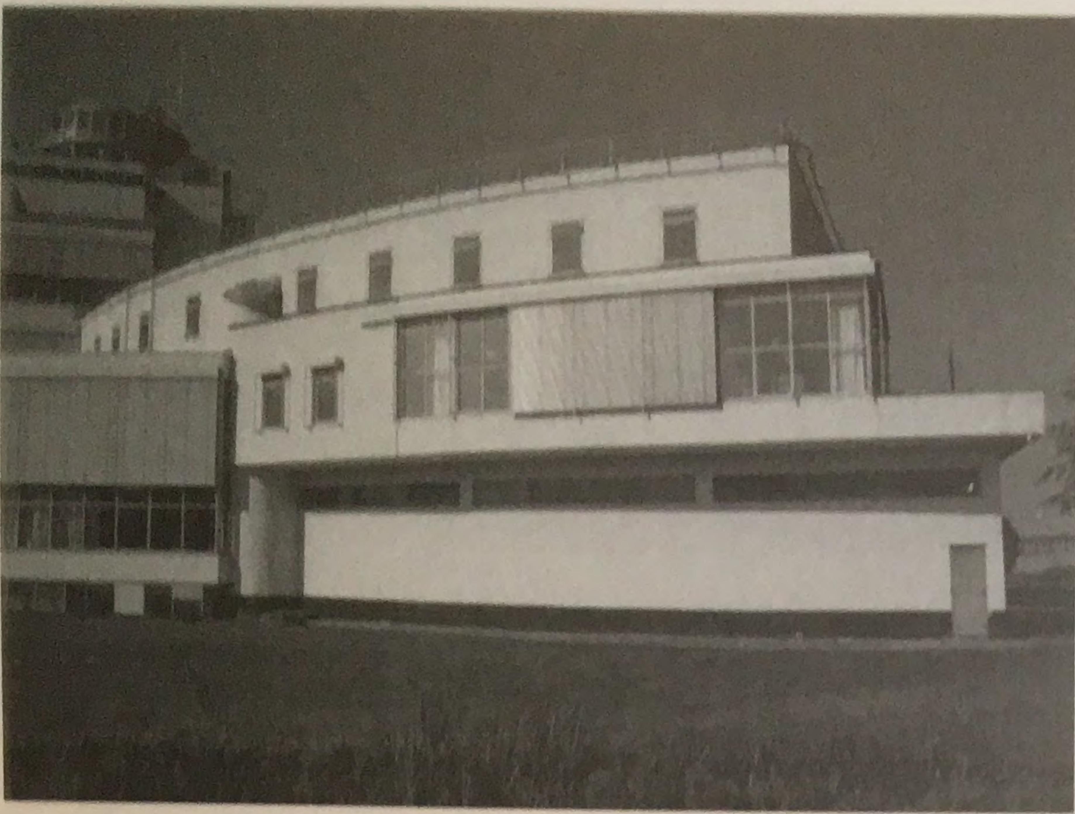
61. El edificio de oficinas restaurado
