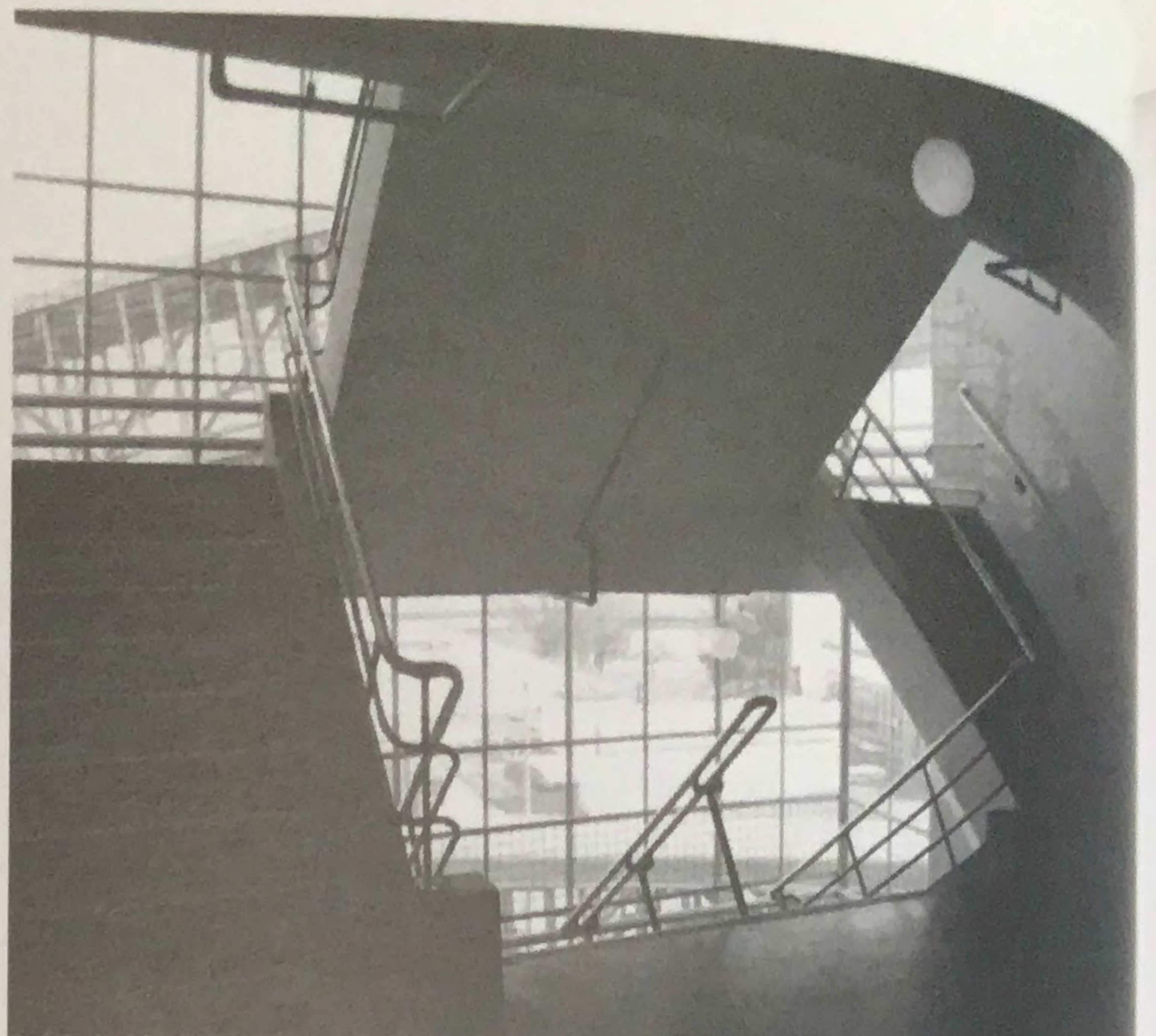
62. En la restauración de las cajas de escalera se pudo recuperar toda pureza del aspecto original
