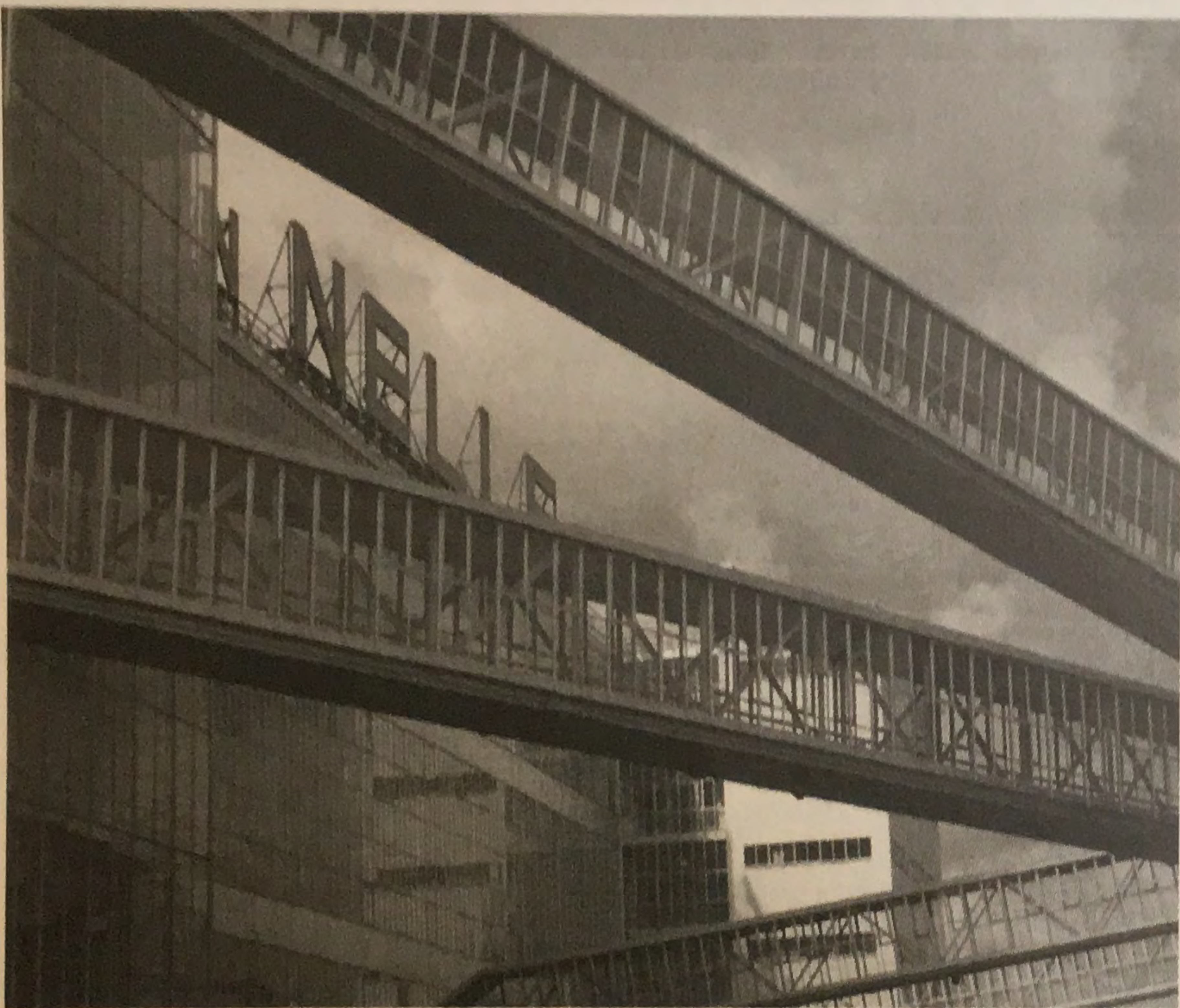
63. Las pasarelas y el neón superior restaurados
