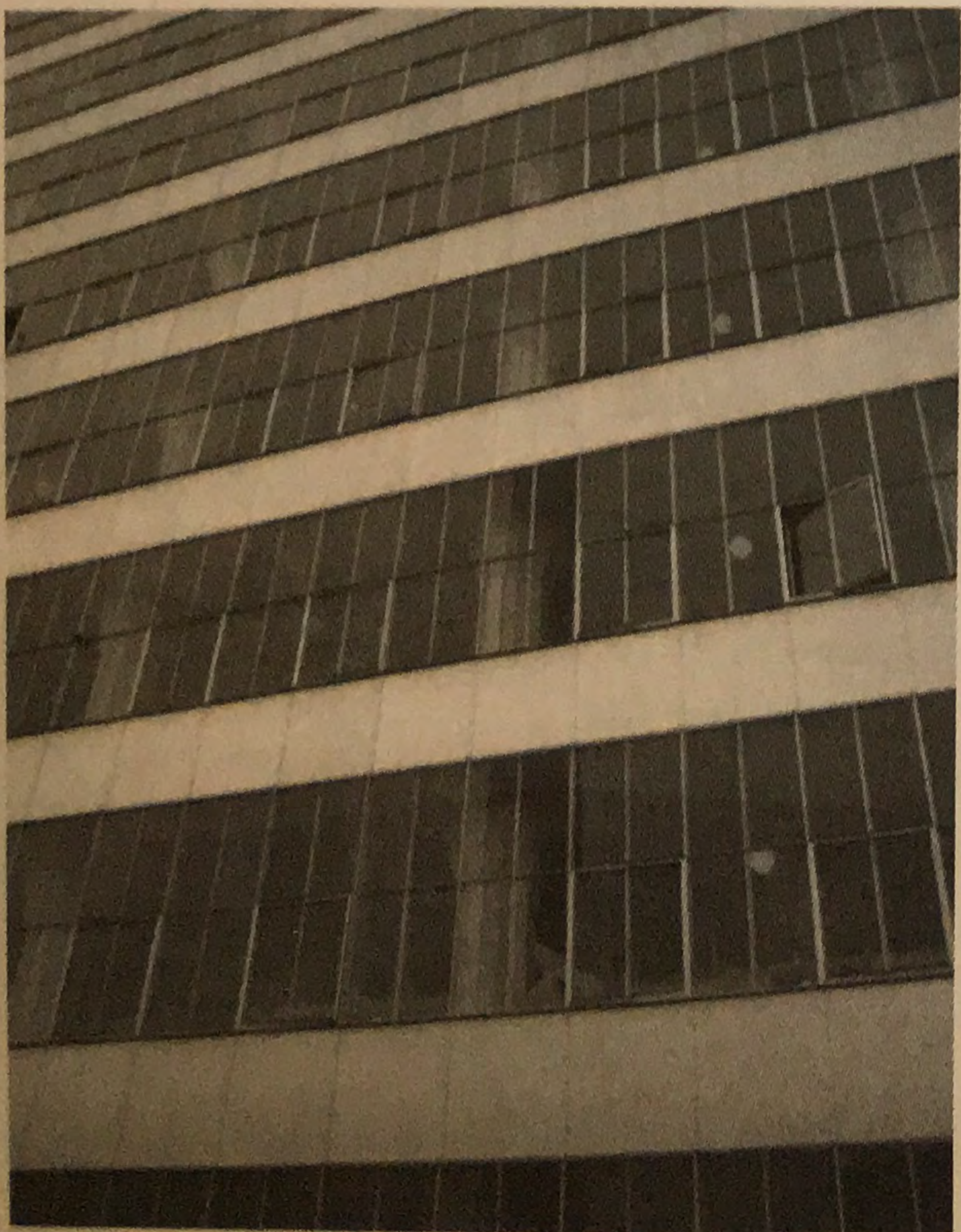
65. y 65 Bís. El exterior restaurado
