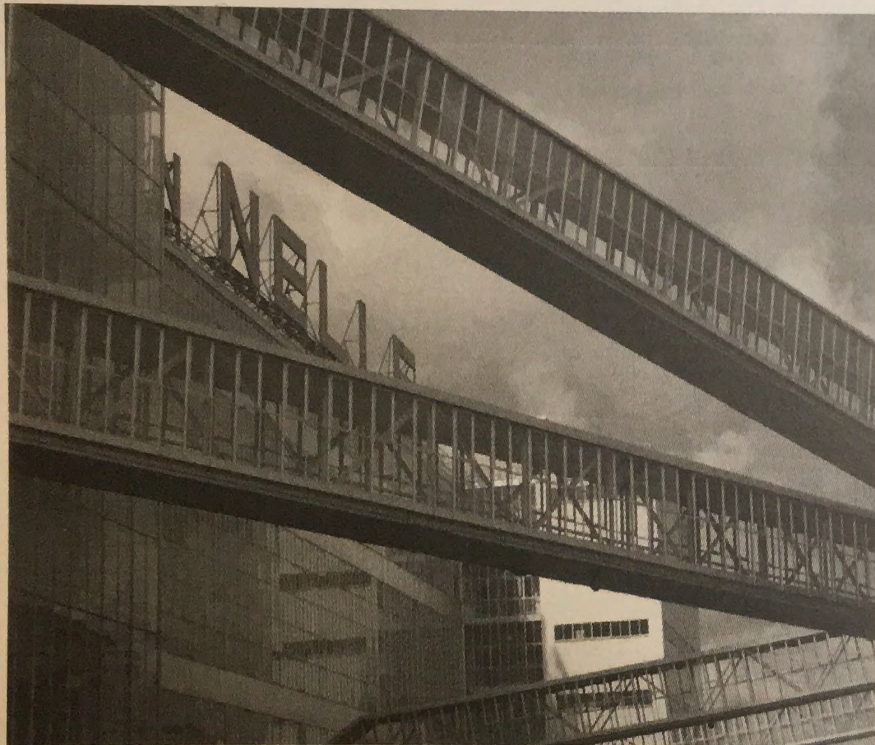
63. Las pasarelas y el neón superior restaurados
