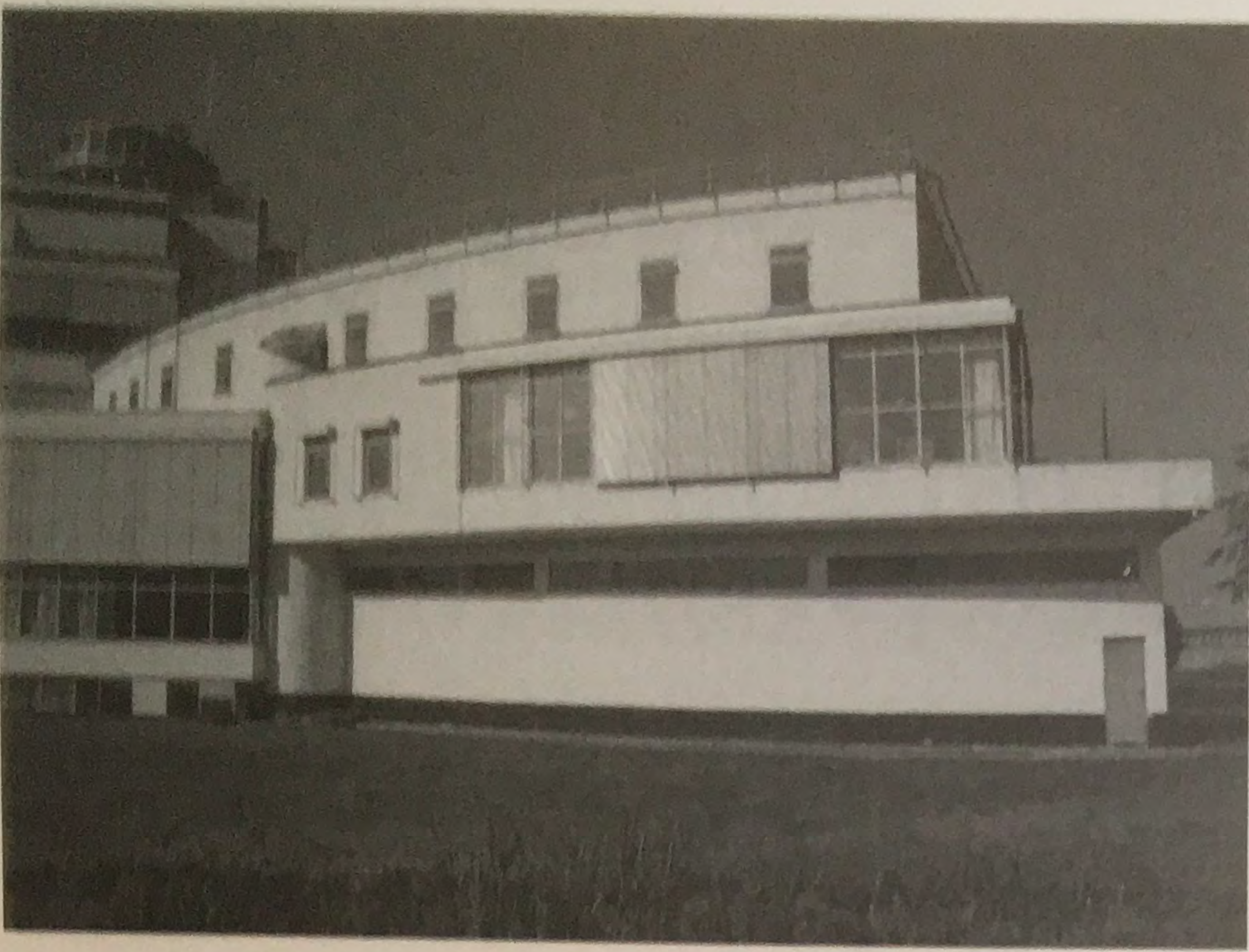
61. El edificio de oficinas restaurado
