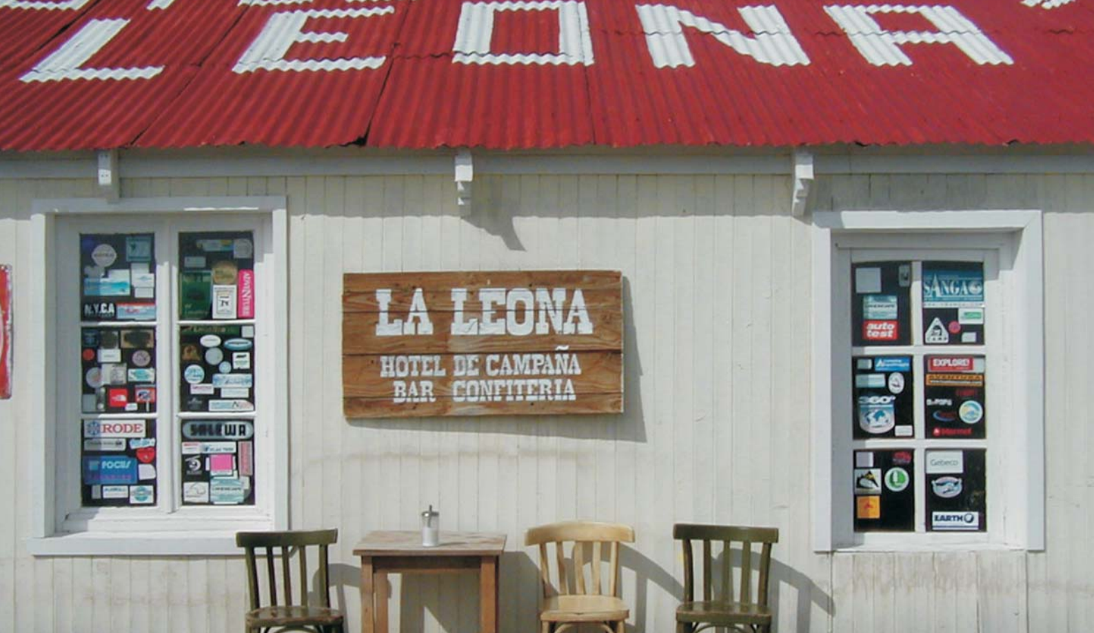
Hotel parador en estancia La Leona, Ruta 40, Santa Cruz. Los gestos antrópicos perdidos en el vacío.
