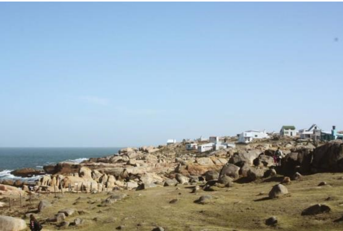
Domo. Construcciones sobre las rocas. Mantenimiento y consolidación selectiva. .
