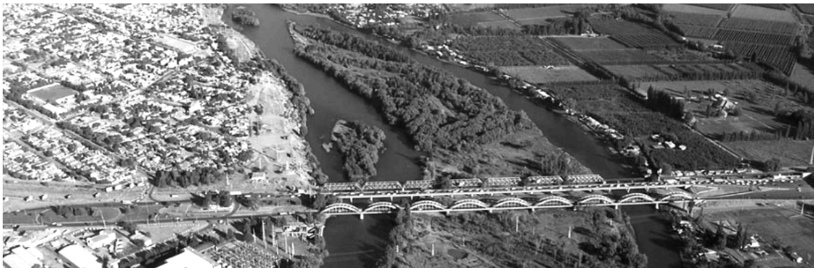
Puente Carretero de Cipolletti-Neuquén.
